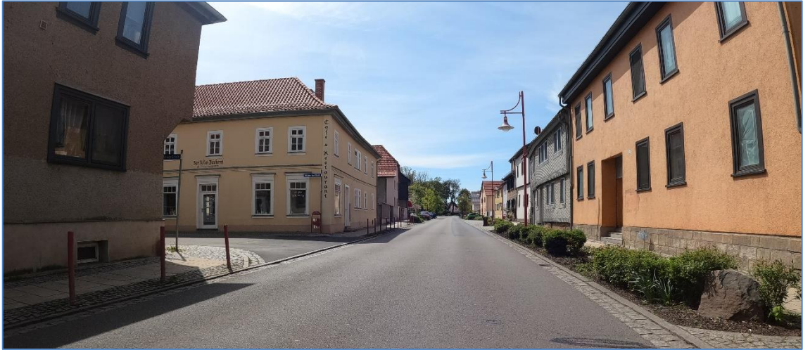
Abb. 15 Bestandssituation Erfurter Straße zw. A.-Bebel-Straße und Friedensallee
